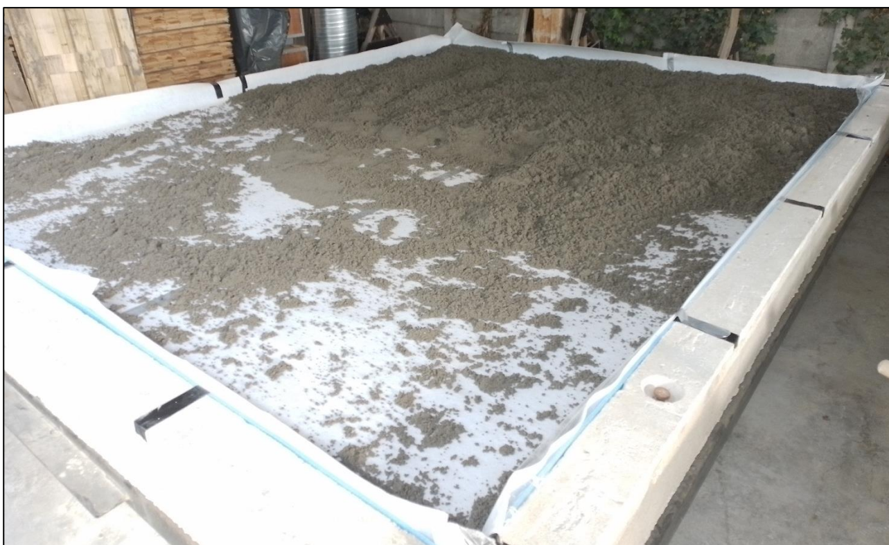
Mise en œuvre de la chape
