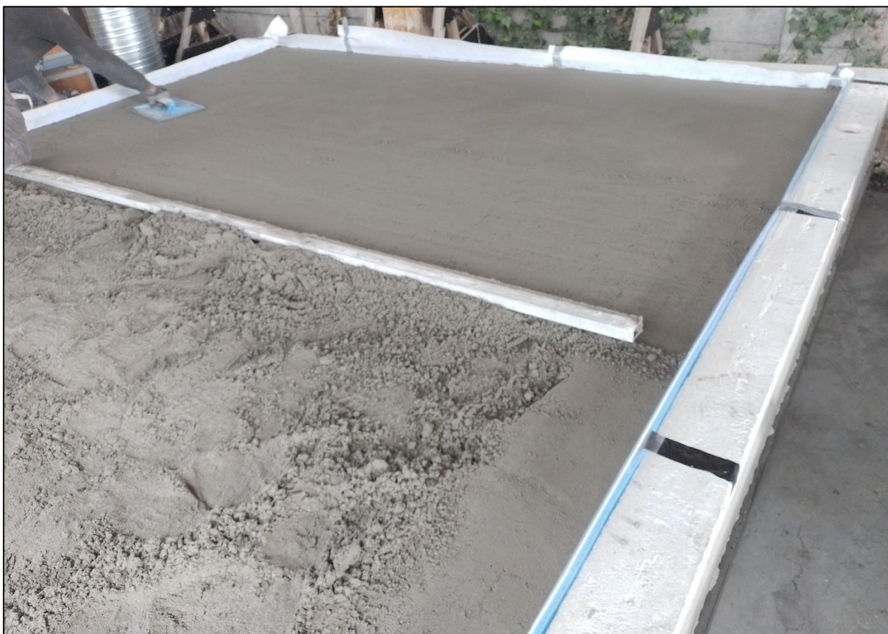
Mise en œuvre de la chape
