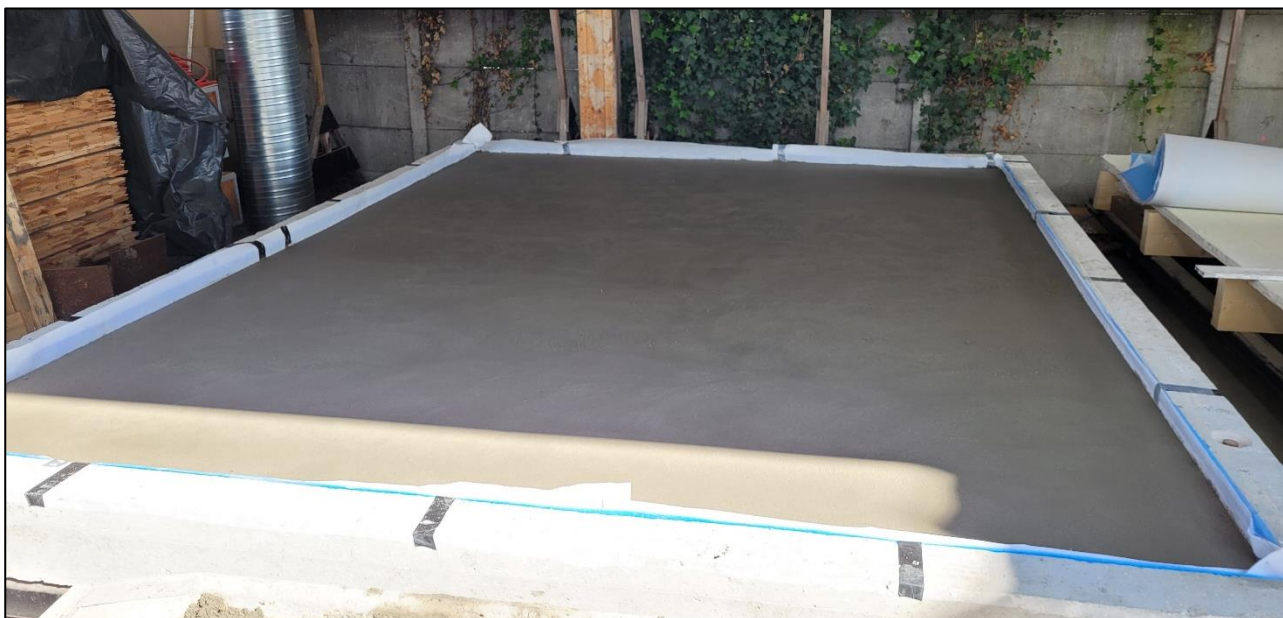
Mise en œuvre de la chape
