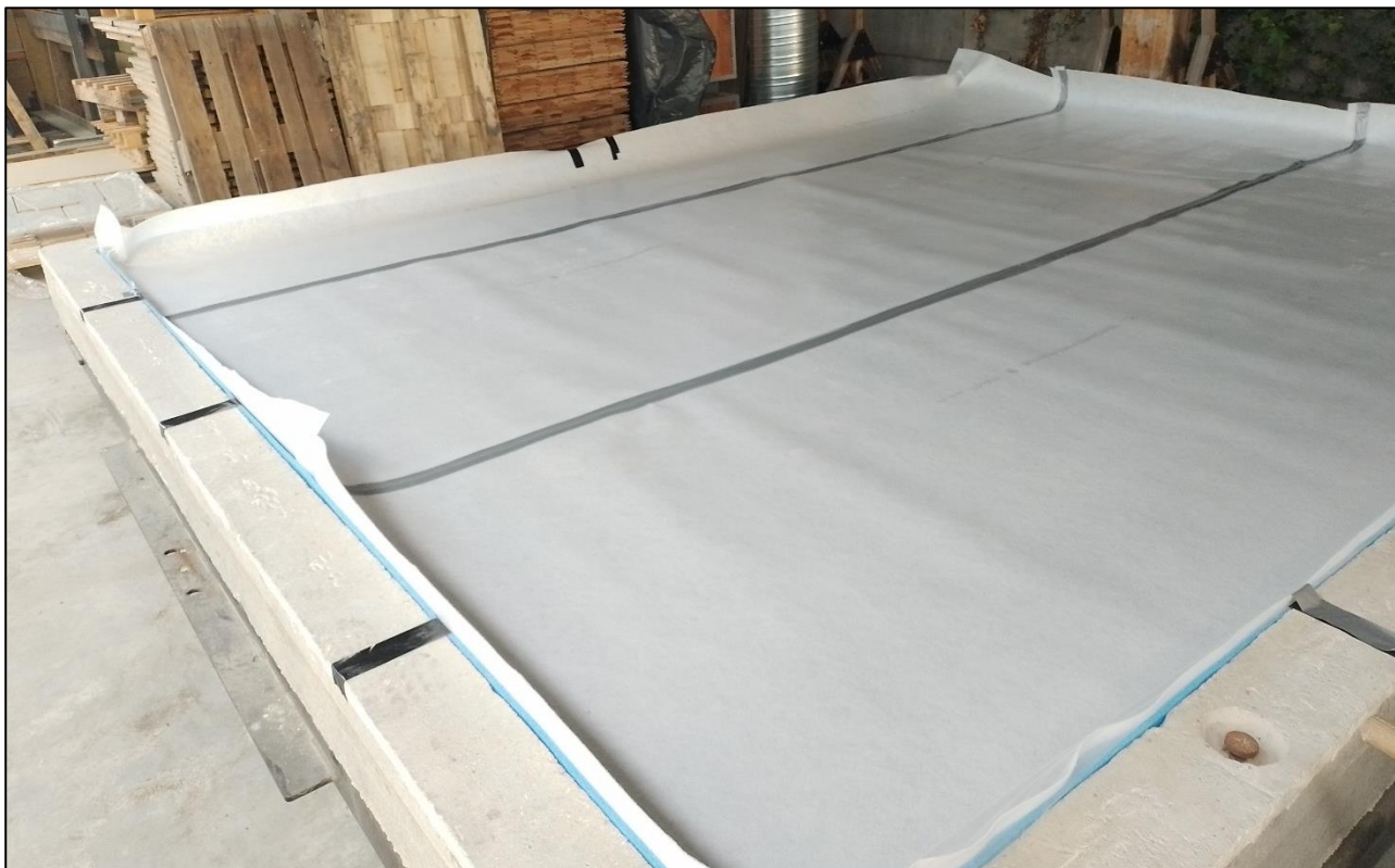
Mise en œuvre de la sous-couche et de la bande de rives
