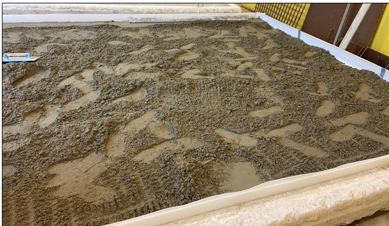
Mise en œuvre de la chape
