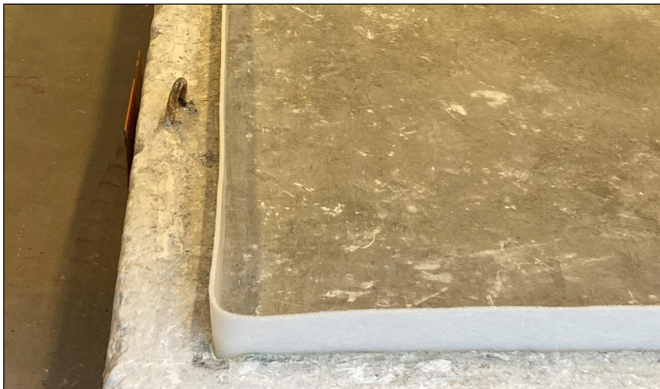
Mise en œuvre de la bande de rives
