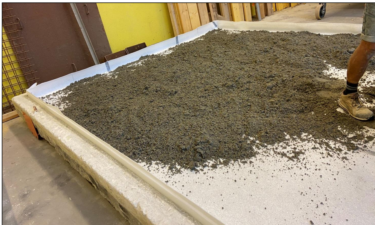
Mise en œuvre de la chape
