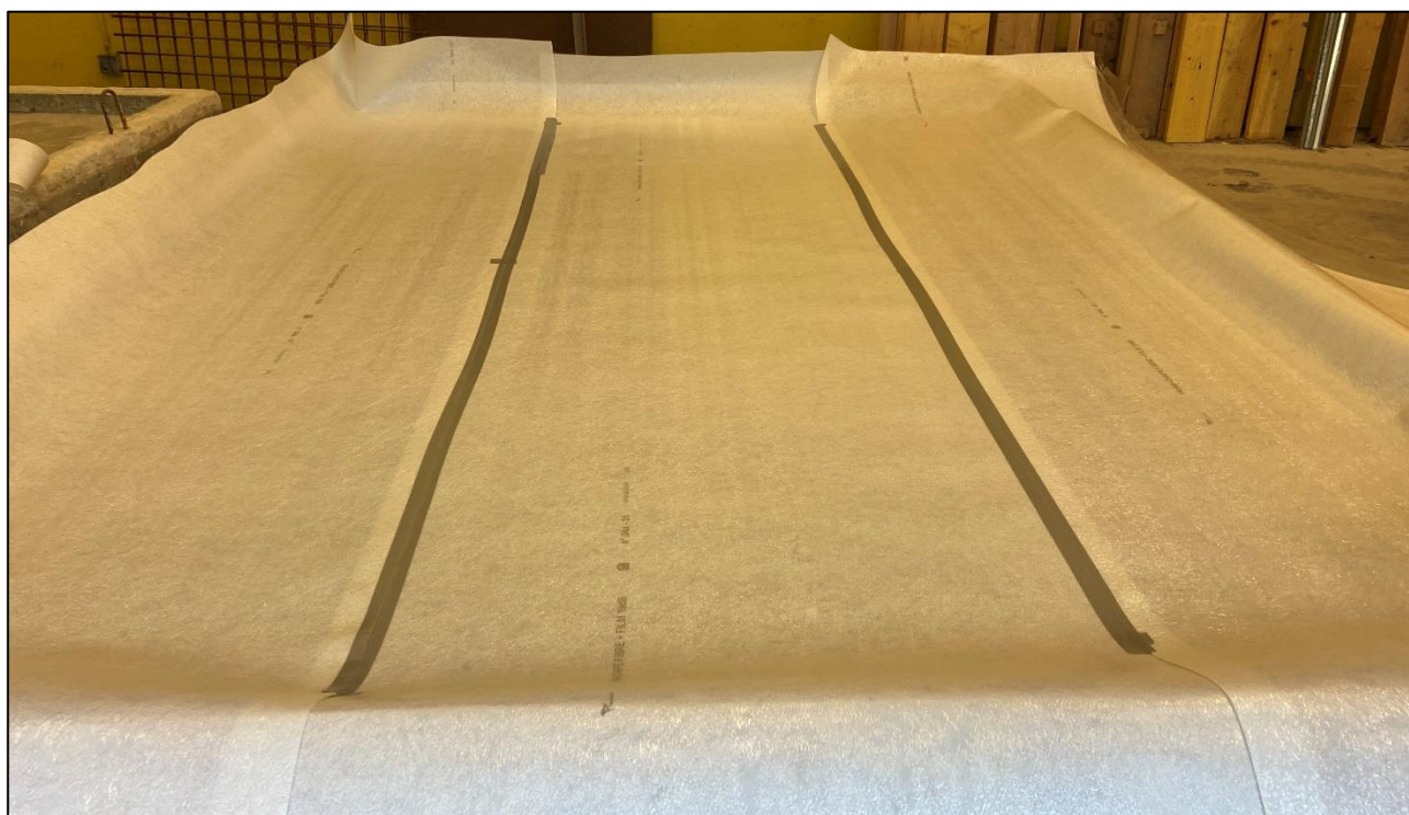
Mise en œuvre de la sous-couche
